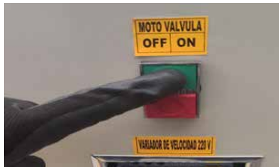
8 Presionar botón ON (verde) para accionar moto válvula
