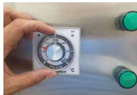
4 Girar pirómetro de placa inferior inferior a temperatura de 160°C
